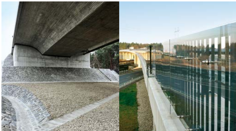
Přeložka silnice I/9 - MÚK Sosnová
