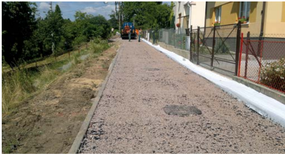
Rekonstrukce Jelínkovi ulice v Kostelci nad Orlicí
